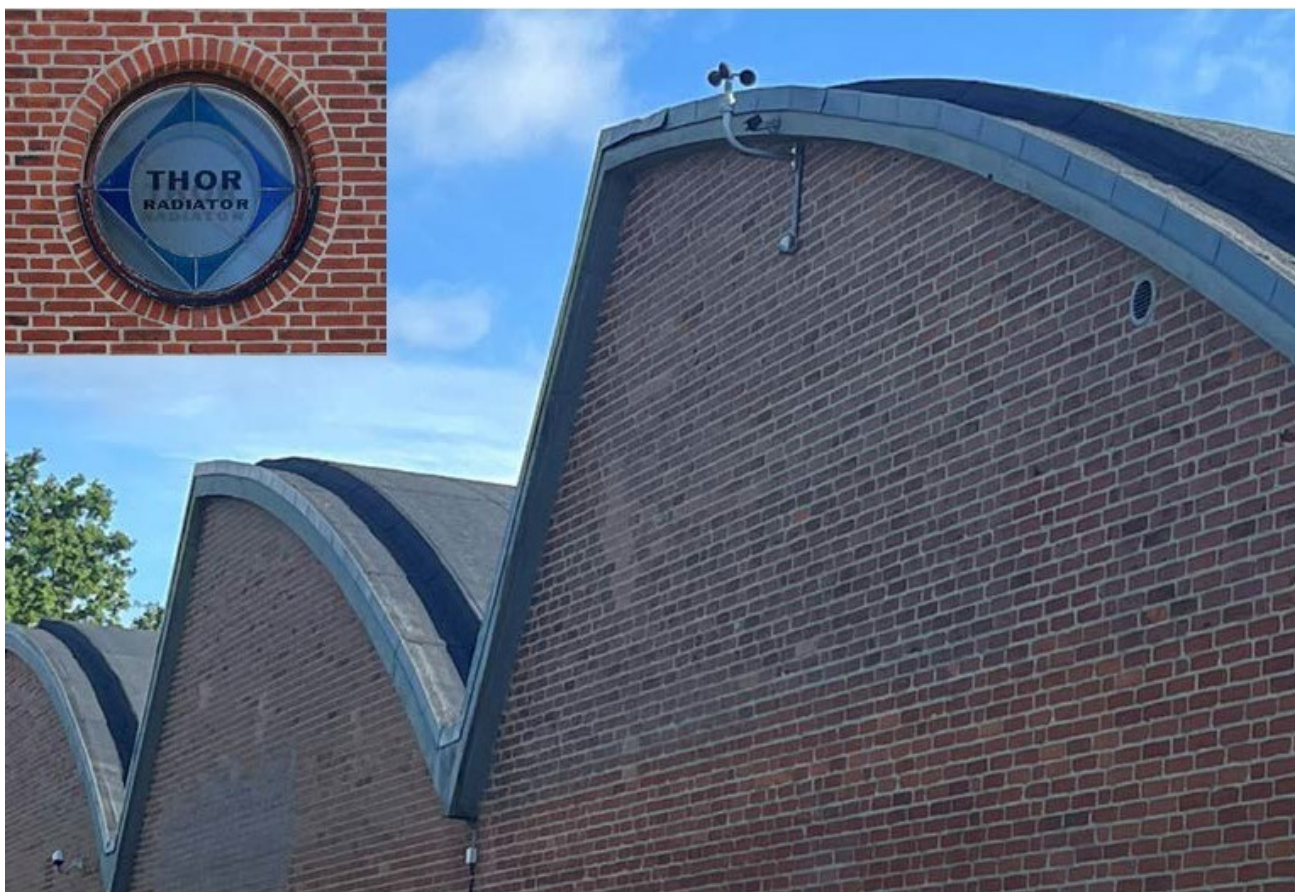
Billede 4: Eksempler på særlige bygninger og detaljer i erhvervs kvarteret (Hørkær 1-3 facadeskilt og tag)
